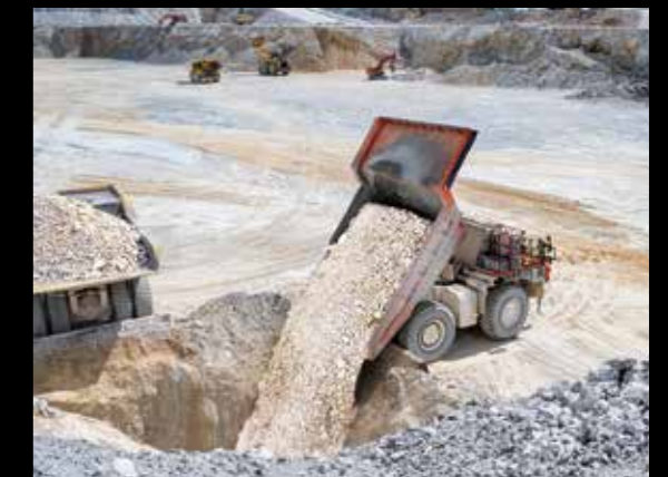
立坑への投入
