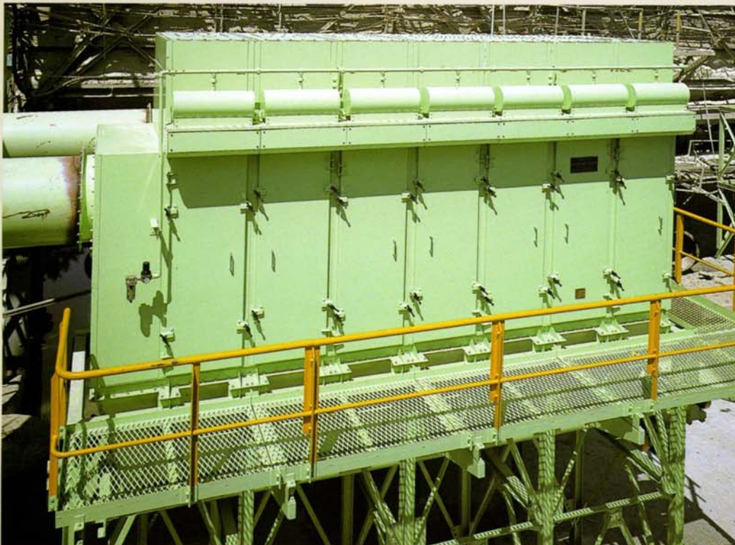
▲型式:HSL-1500-56/18-KH-SR(処理風量580m 3 /min)
