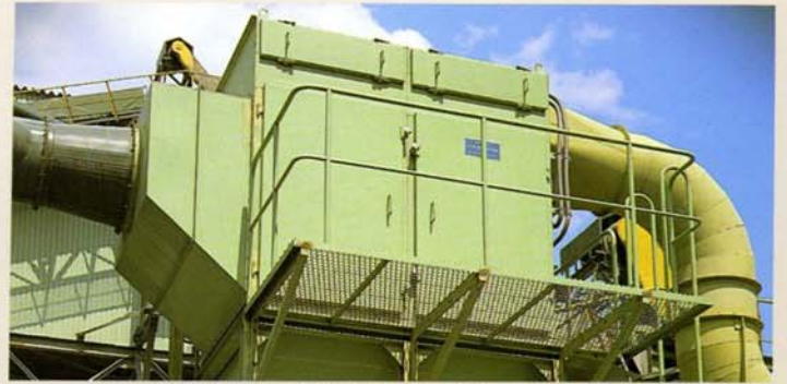
▲型式:HSL-1500-32/18-KH-F-R(処理風量400m 3 /min)
