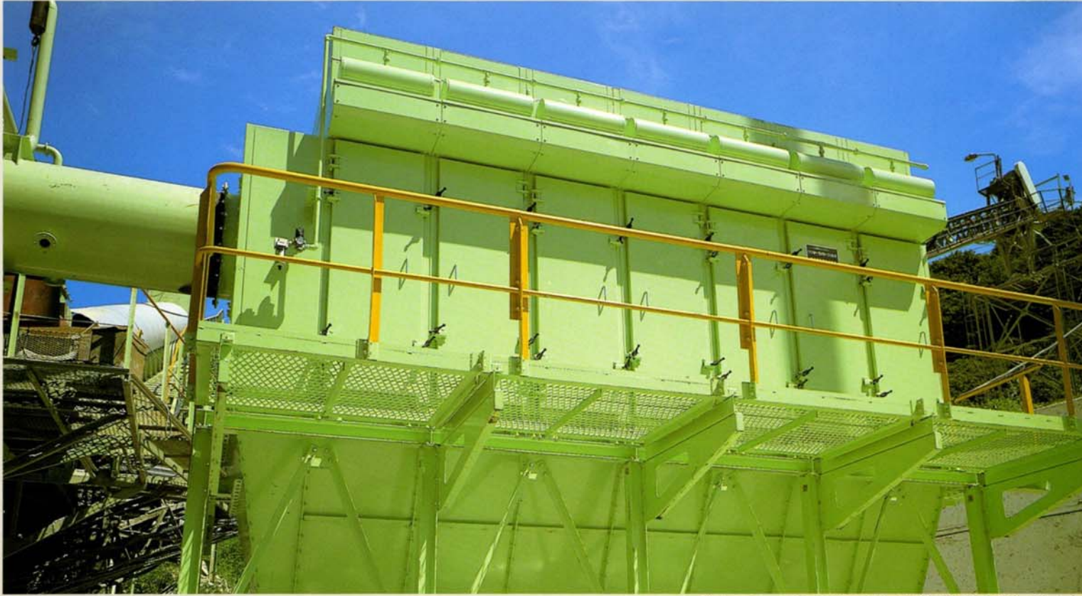
▲型式:HSL-1500-56/18-KH-SR(処理風量450m 3 /min)
