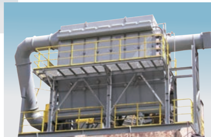
採石所環境集塵 型式: HSL-1500-56/18-KH 処理風量: 500m 3 /min W: 5400mm H: 2600mm D: 1600mm
