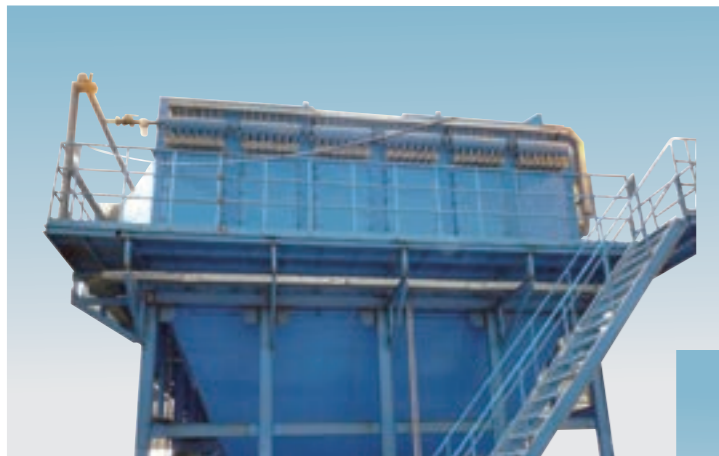
製鉄所環境集塵 (中国) 処理風量: 1500m 3 /min
