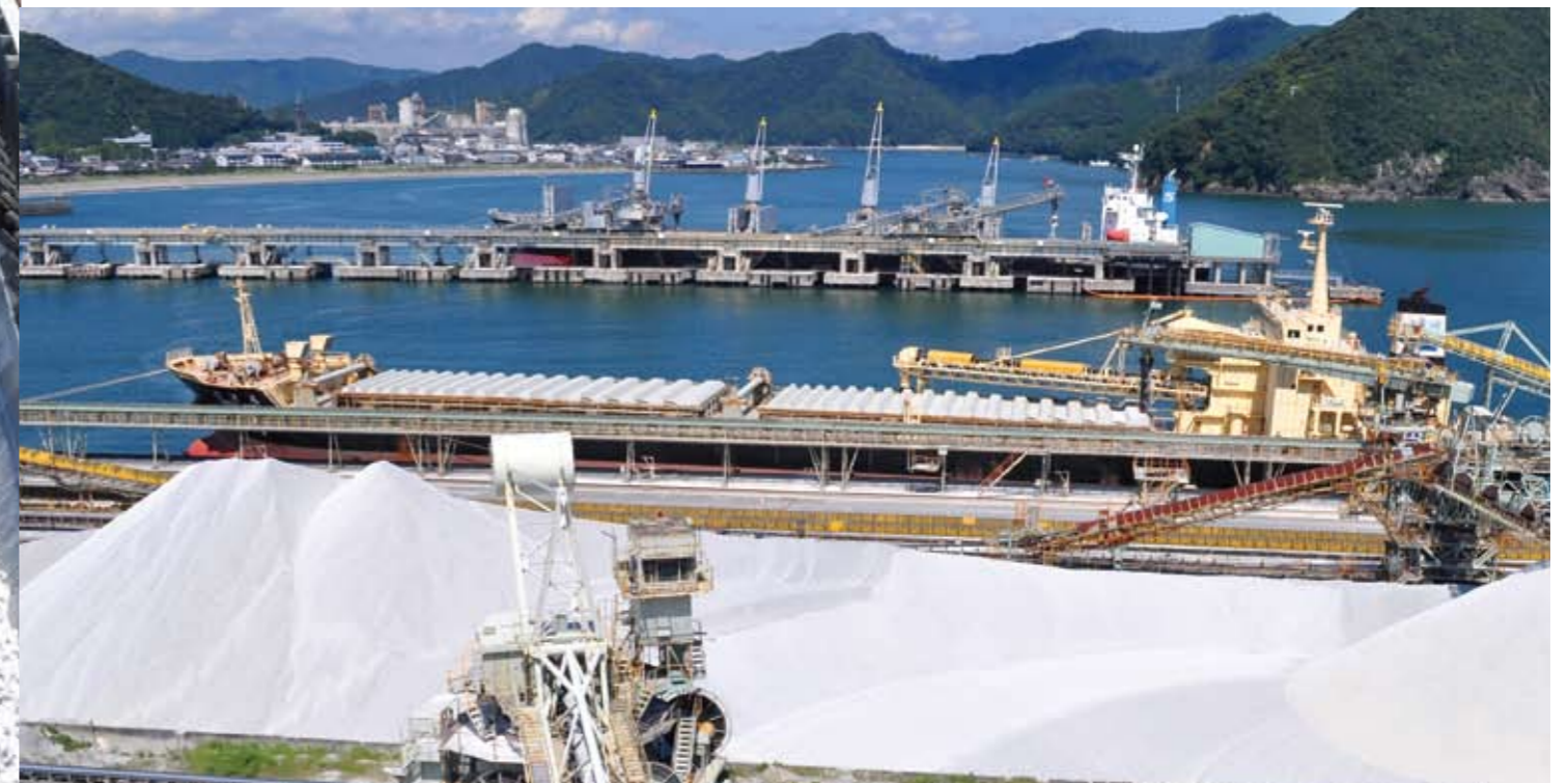
海上栈橋及び岸壁バース
