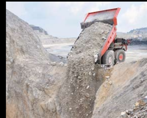
立坑への投入
