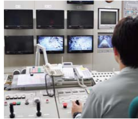
山元中央制御室内で行う小割の遠隔作業
